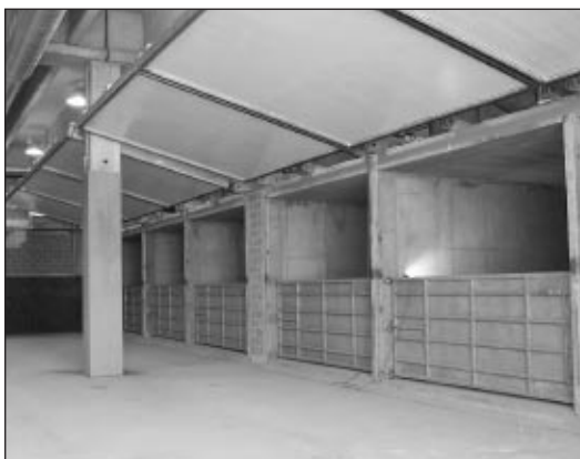
Le biocelle a tenuta stagna sono il "cuore" del nuovo impianto
