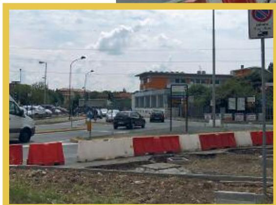
*Lavori di abbozzo della nuova intersezione a rotonda fra viale Lombardia e via Buonarroti, che sostituisce il vecchio incrocio regolato da semafori*
