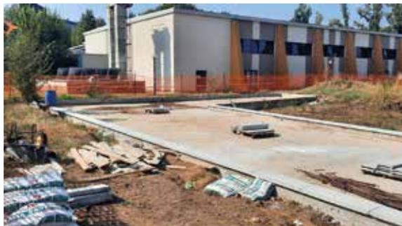
demolizione dell'attuale struttura verticale e di completamento della platea mediante realizzazione di un massetto, rinforzo dello stesso con rete elettrosaldata e finitura con pavimento granulato sferoidale di quarzo.
