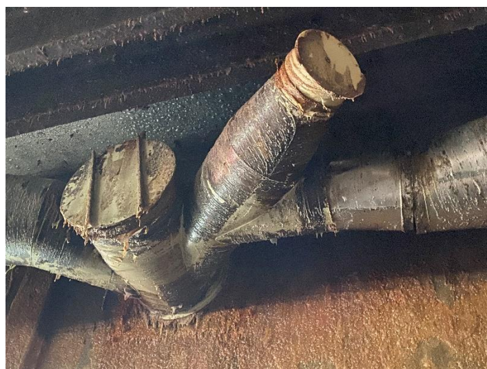
Foto 11 – Particolare del sottotetto
