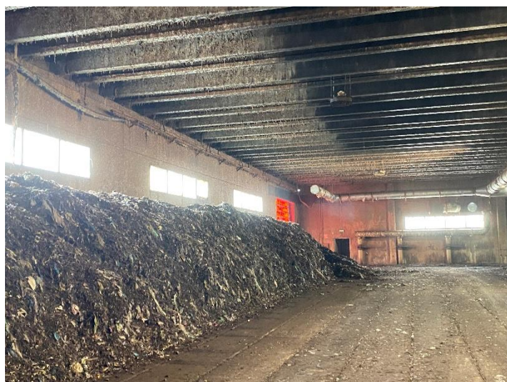
Foto 8 – Vista area maturazione primaria
